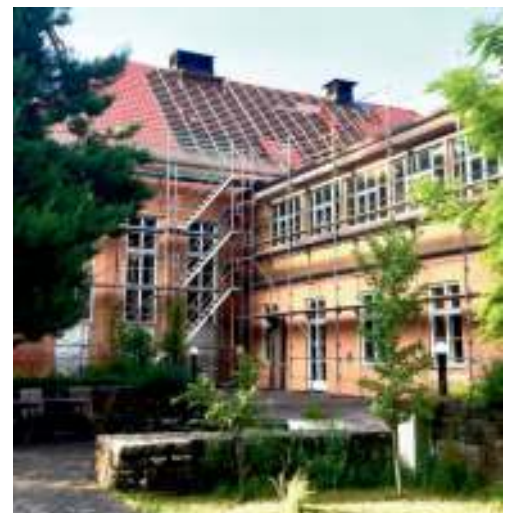
Dachsanierung DAS HAUS
